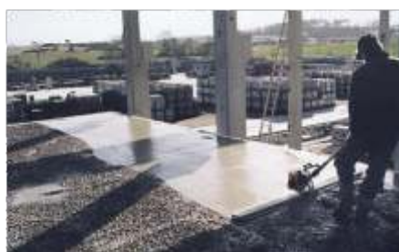
Obr. 16 - Zpracování uložené betonové směsi
