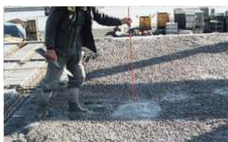
Obr. 15 - Kontrola výšky nadbetonování
