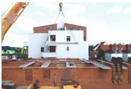
Obr. 3 - Manipulace se stropními trámcí na stavbě
