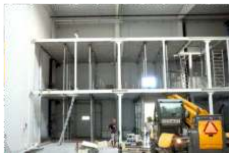
Obr. 6- Podepření strop nad sebou při více podlažích
