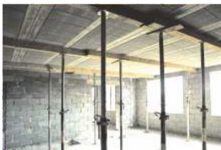
Obr. 5 - Podepření stropu-pohled zdola
