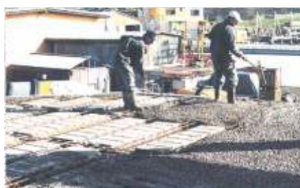
Obr. 14 - Ukládání betonu v ploše stropní konstrukce
