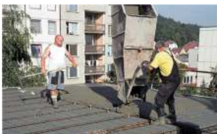
Obr. 13 - Betonáž pomocí bádie
