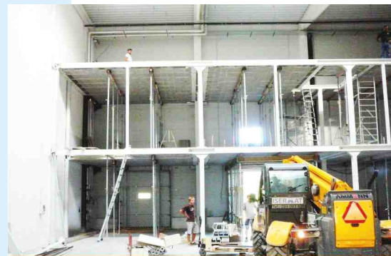
Podepírání stropů nad sebou
