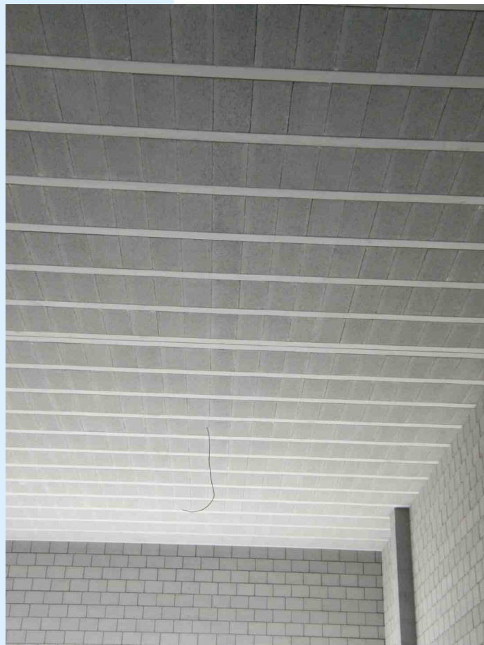
stropní konstrukce a zdivo BSG po nástřiku BS HYDROFOB
