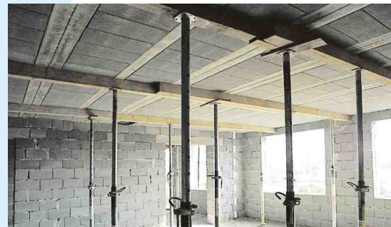
Podepření stropní konstrukce – pohled zdola
