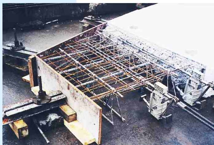
Přerušení tepelných mostů pomocí ISO - nosníků
