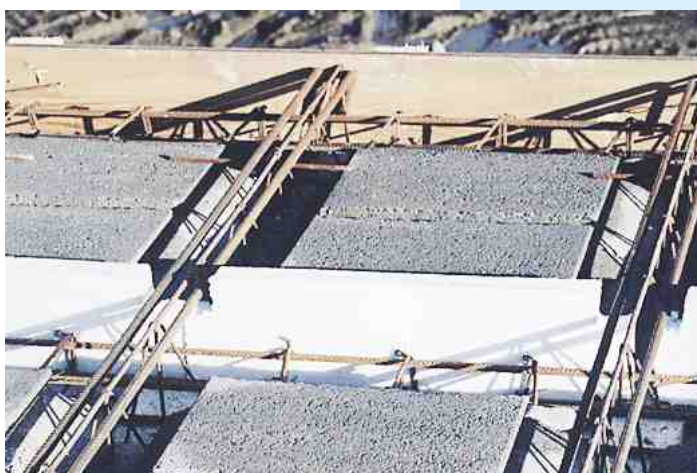
Přerušení tepelných mostů polystyrenem ve tvaru vložek
