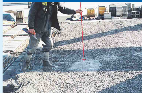
Kontrola výšky nadbetonování
