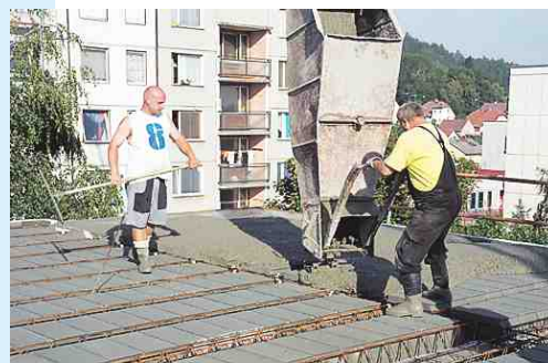
Betonáž stropu pomocí bádie
