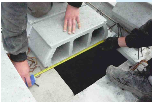
Uložení stropní vložky
