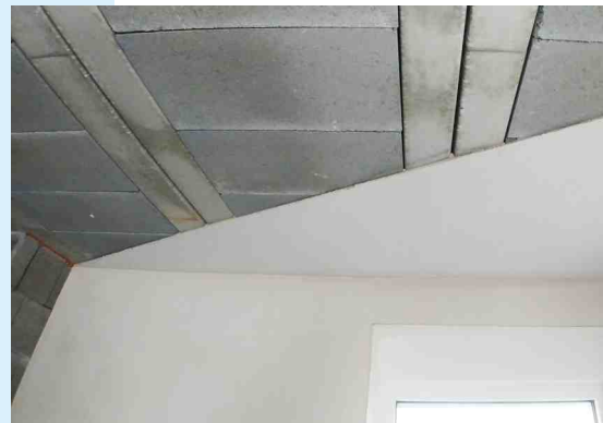
ukázka jednovrstvé omítky na stropní konstrukci BSG - STROP
