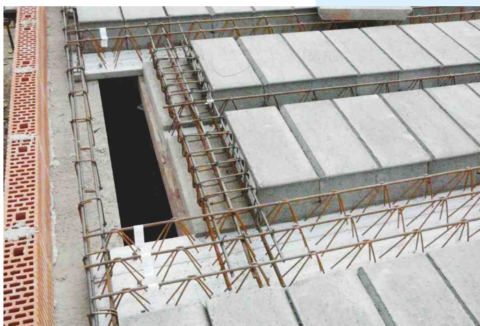
Výztuž stropní výměny
