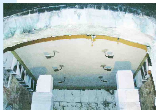
Strop před zkouškou
