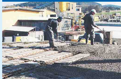
Ukládání betonu v ploše stropní konstrukce
