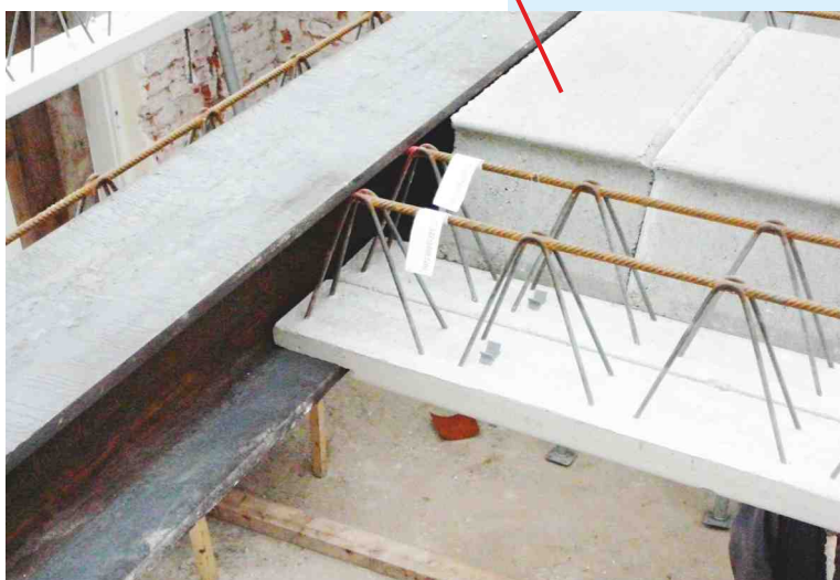
Osazení stropního trávce do ocelového nosníku
