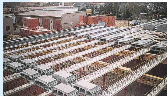
Rozmístění stropních trámů a vlozek
