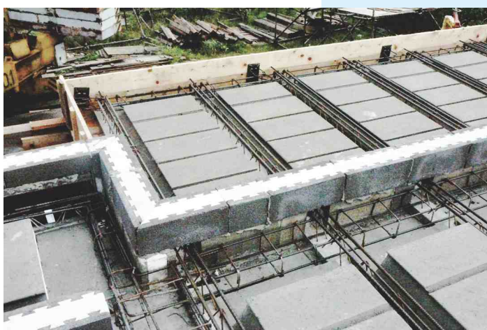
Bednění balkónu s plechy pro kotvení zábradlí
