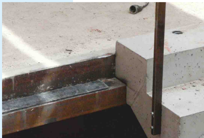
Osazení schodiště na ocelový ozub
