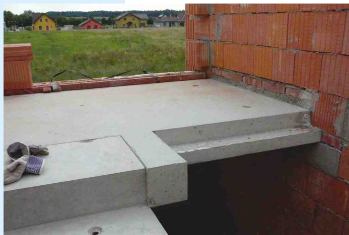
Osazení schodiště na prefabrikovaný ozub
