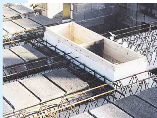
Dřevěné bednění prostupu
