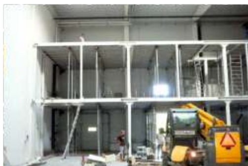
Obr. 6- Podepření stropů nad sebou při více podlažích
