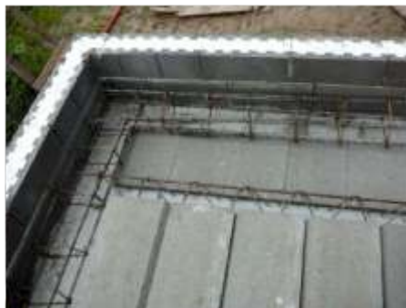
Obr. 10 - Provazba rohu ztužujícího v nce
