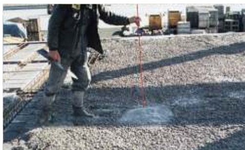
Obr. 15 - Kontrola výšky nadbetonování
