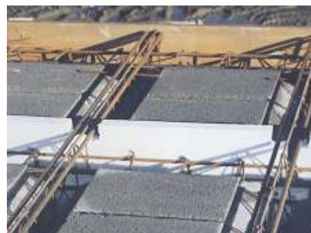
Obr. 11 - P erušení tepelného mostu
