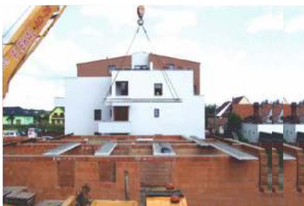
Obr. 3 - Manipulace se stropními trámy na stavbě
