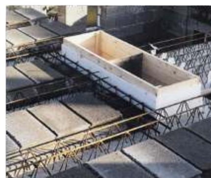
Obr. 12 - D ev ěné bedn ění prostupu
