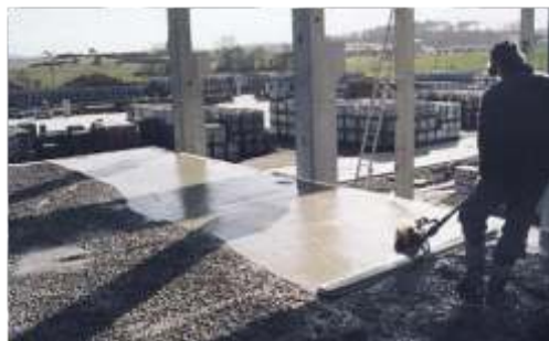
Obr. 16 - Zpracování uložené betonové směsi
