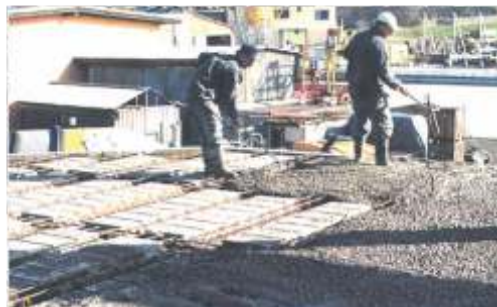
Obr. 14 - Ukládání betonu v ploše stropní konstrukce
