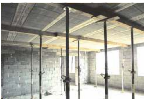
Obr. 5 - Podepření stropu-pohled zdola
