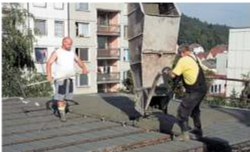
Obr. 13 - Betonáž pomocí bádie
