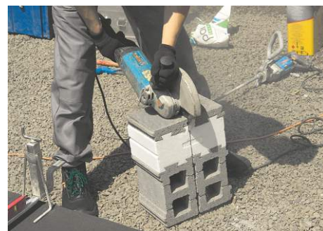
Ruční řezání tvárnic vidiovým kotoučem.
