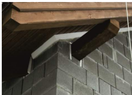
b) tepelná izolace je svedena i po vnitřní štítové zdi až do výšky střešní izolace
