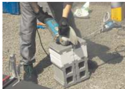
Ruční řezání tvárnice vidiovým kotoučem.
