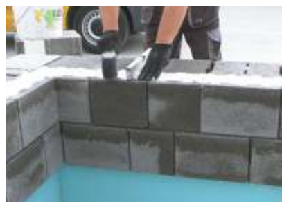
Ruční řezání tvárnice vidiovým kotoučem.
