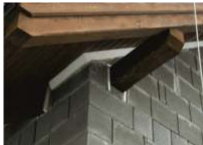
b) tepelná izolace je svedena i po vnitřní štítové zdi až do výšky střešní izolace
